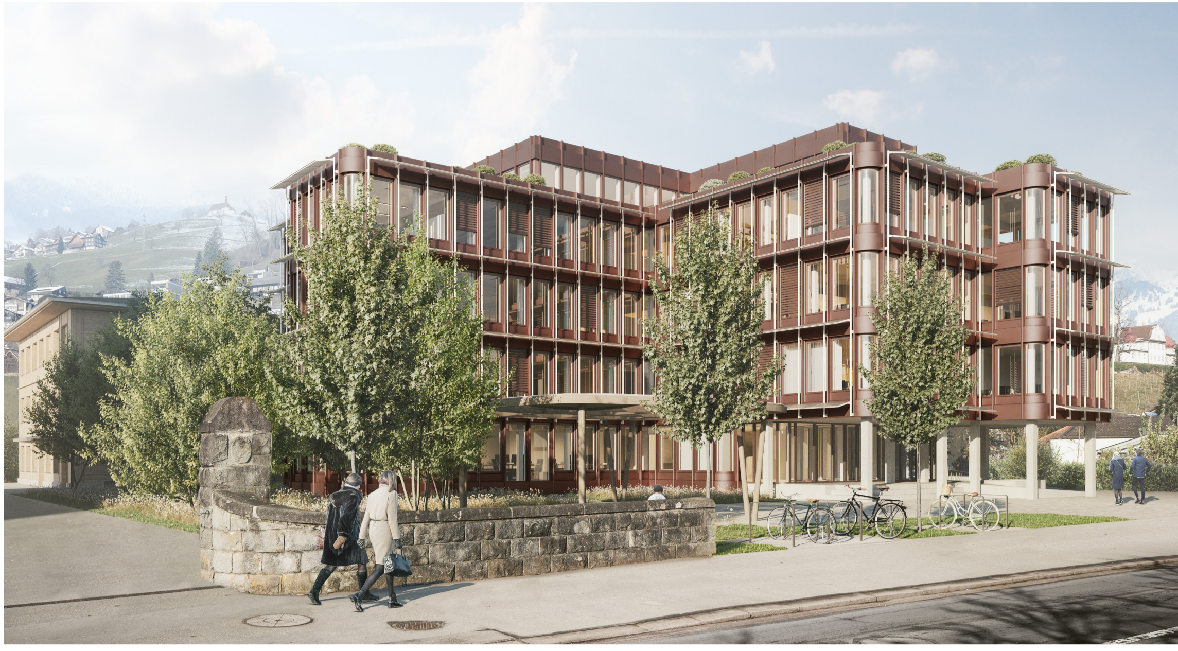
Gemeindehaus, im Hintergrund das Multifunktionsgebäude.
